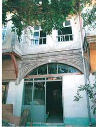
Res. 7. Dış cephesi.
