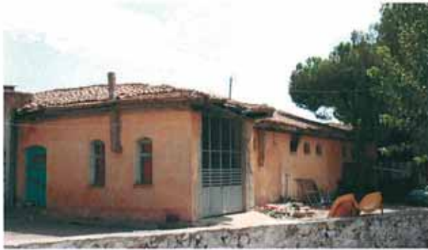
Res.30. Eski hâl binası (env. no: J18.B5.1658).
