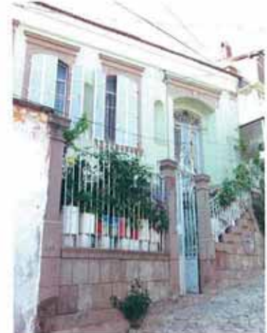
Res. 17. Aynı evin dış cephesi.
