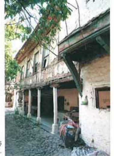
Res. 4. Evin dış görünüşü.
