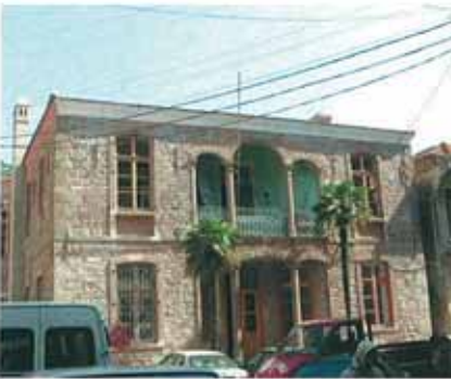
Res. 23. Eski Belediye binası (env. no: J18.B5.1494).
