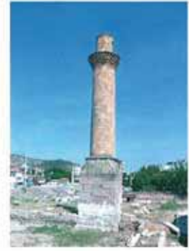
Res. 37. Emirsultan Minaresi (env. no: J18.B5.1226).
