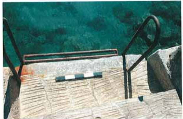
Res. 28. İskele mevkiinde, beton iskeledeki devşirme taşlar.
