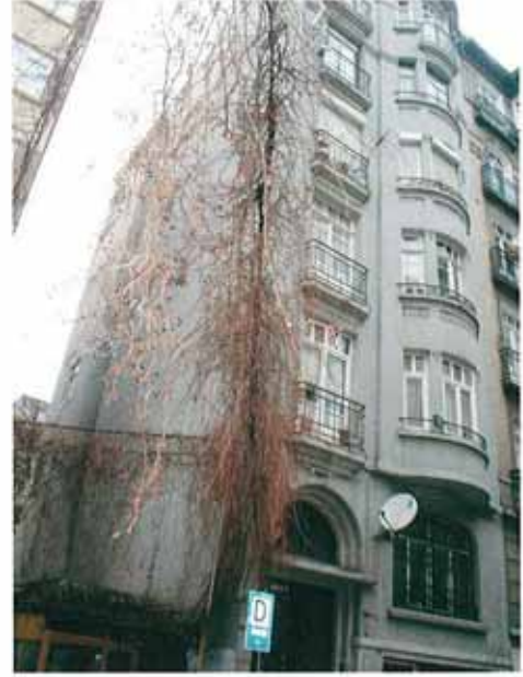
Res. 2. Şimşirci Sokağı no. 11, (env. no: F21.B10.113)
