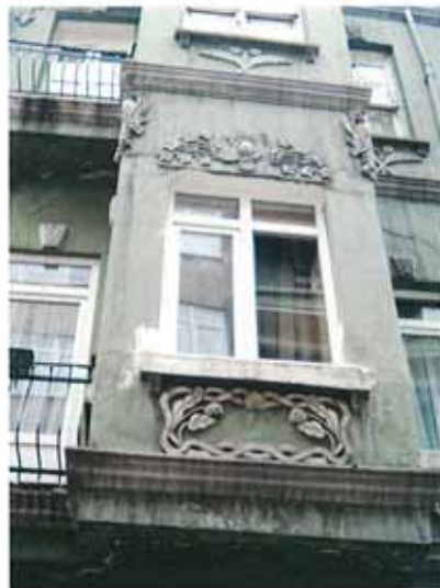
Res. 6. Havyar Sokağı no. 6-8, (env. no: F21.B10.88).
